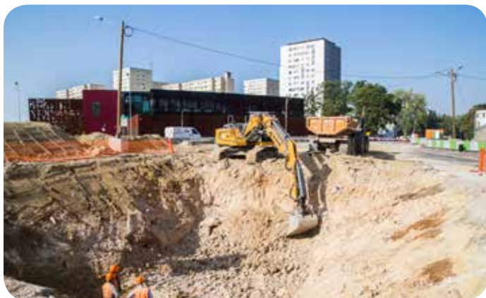
Travaux boulevard Gagarine à Clichy-sous-Bois
